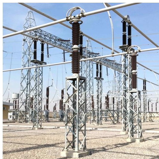
شکل ۶- نمونه‌ای از سازه‌های موجود در ایستگاه‌های فوق توزیع برق ساخته شده از فولاد گرم نورد شده
