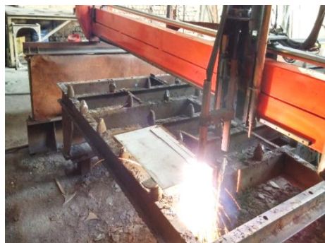
شکل ۹- برش کاری ورق فولادی با دستگاه CNC
