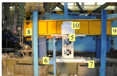
شکل (۱۰): نمایش برخی از تغییر مکان سنج‌های نصب شده بر روی نمونه‌های آزمایشگاهی
