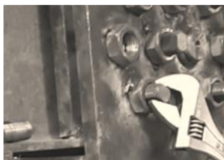
شکل ۲۳- محکم کردن میراگر در مهره توسط آچار
